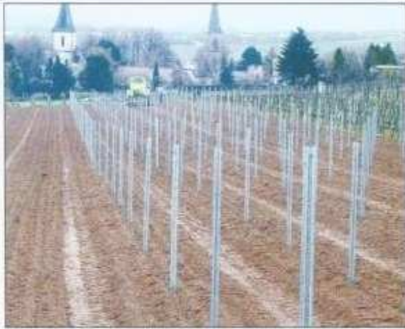
Pfähle werden aufgestellt
